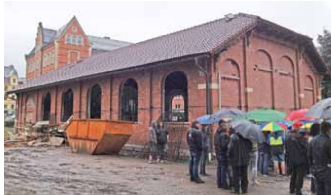
Während im Vordergrund die bereits entkernte Turnhalle steht, thront im Hintergrund die Bürgerschule.
