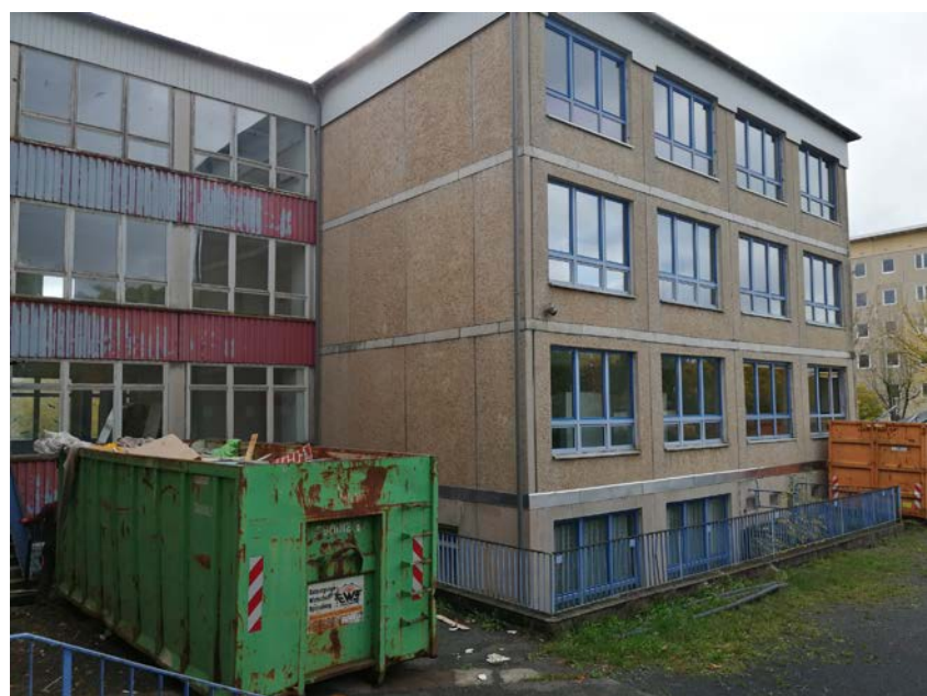
Mit der Entkernung begann Ende Oktober 2023 die Generalsanierung der Regelschule „Cuno Hoffmeister“ Sonneberg.
