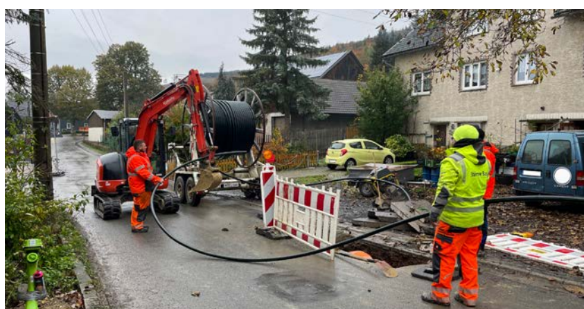
Arbeiten zum Breitbandausbau im Landkreis Sonneberg
