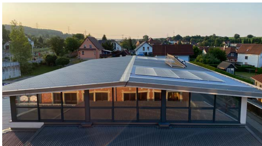
Auf dem Dach der Turnhalle der Gemeinschaftsschule Schalkau wurde im Auftrag des Landkreises Sonneberg eine Fotovoltaikanlage installiert. Sie senkt die Energiekosten und ist ein Beitrag zum Klimaschutz.
