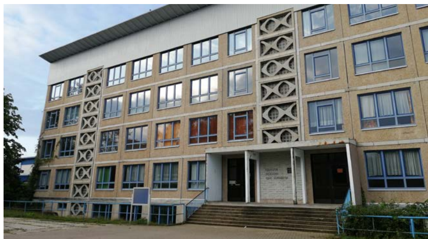
Das Großprojekt des Landkreises Sonneberg zur Sanierung der Regelschule „Cuno Hoffmeister“ Sonneberg mit integrierter Volkshochschule steht kurz vor dem offiziellen Beginn. In den Sommerferien wurde die Schule freigezogen.
