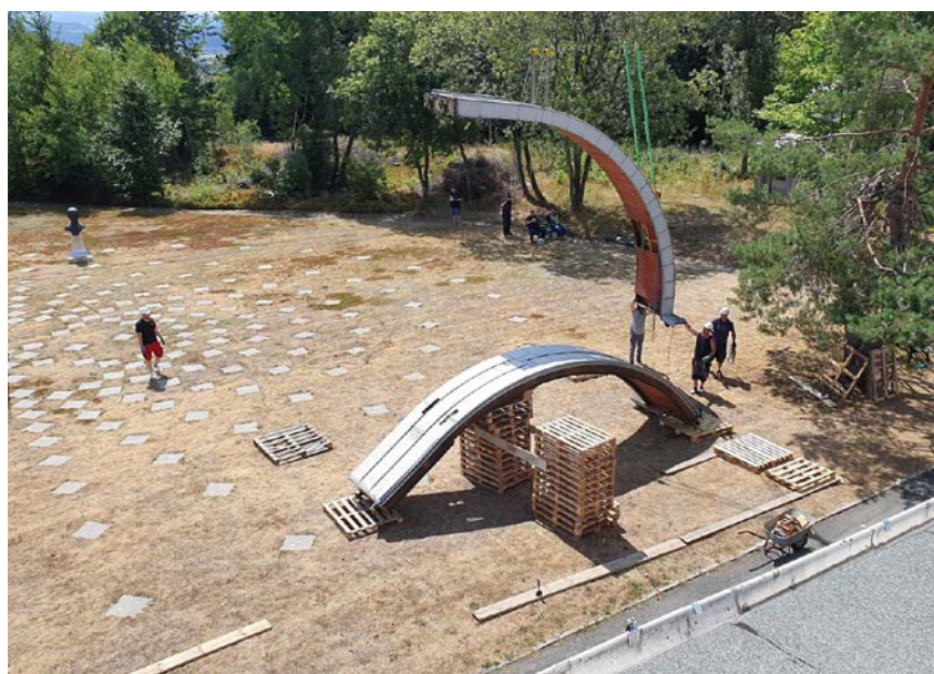
Die Spalttore werden auf der SkyPole-Wiese der Sternwarte zur weiteren Reparatur abgelegt. Aufnahme: Peter Kroll, Sternwarte
