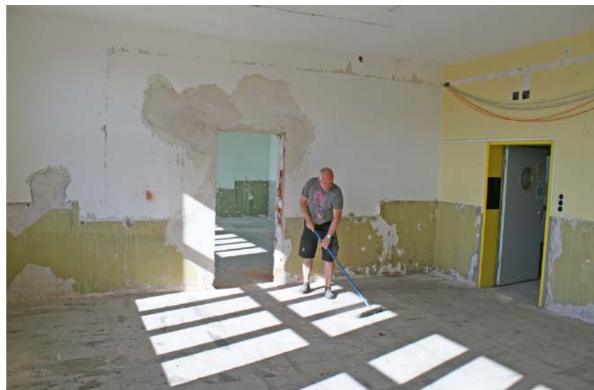
In der Grundschule „Grube“ wurden zwei Klassenräume entkernt und saniert.
