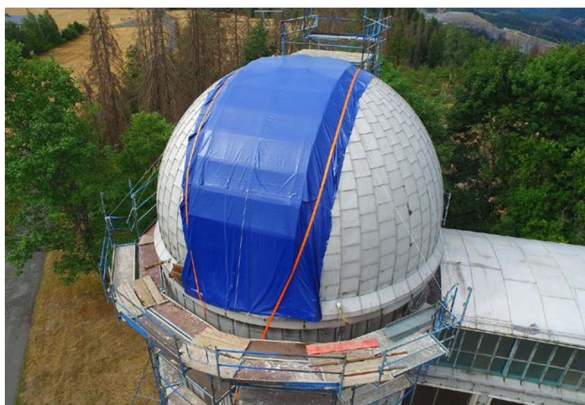
Übergangsweise Verkleidung des Kuppelspalts.
