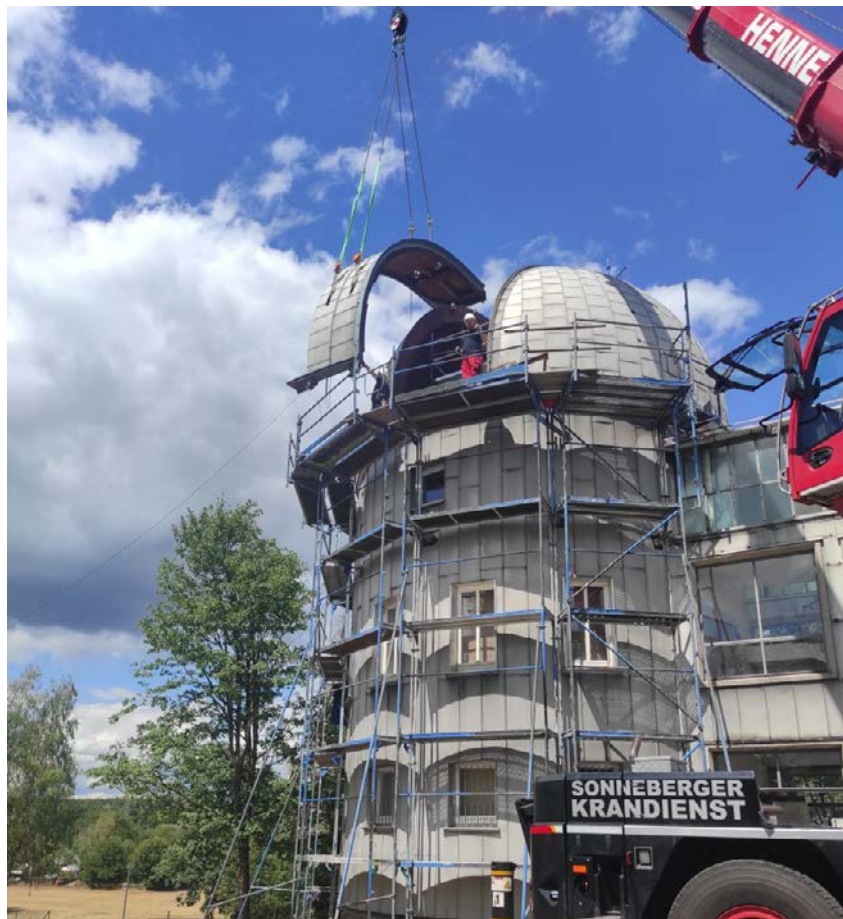
Abheben des zweiten Kuppeltors. Aufnahme: Jürgen Heyne / 4H JENA engineering
