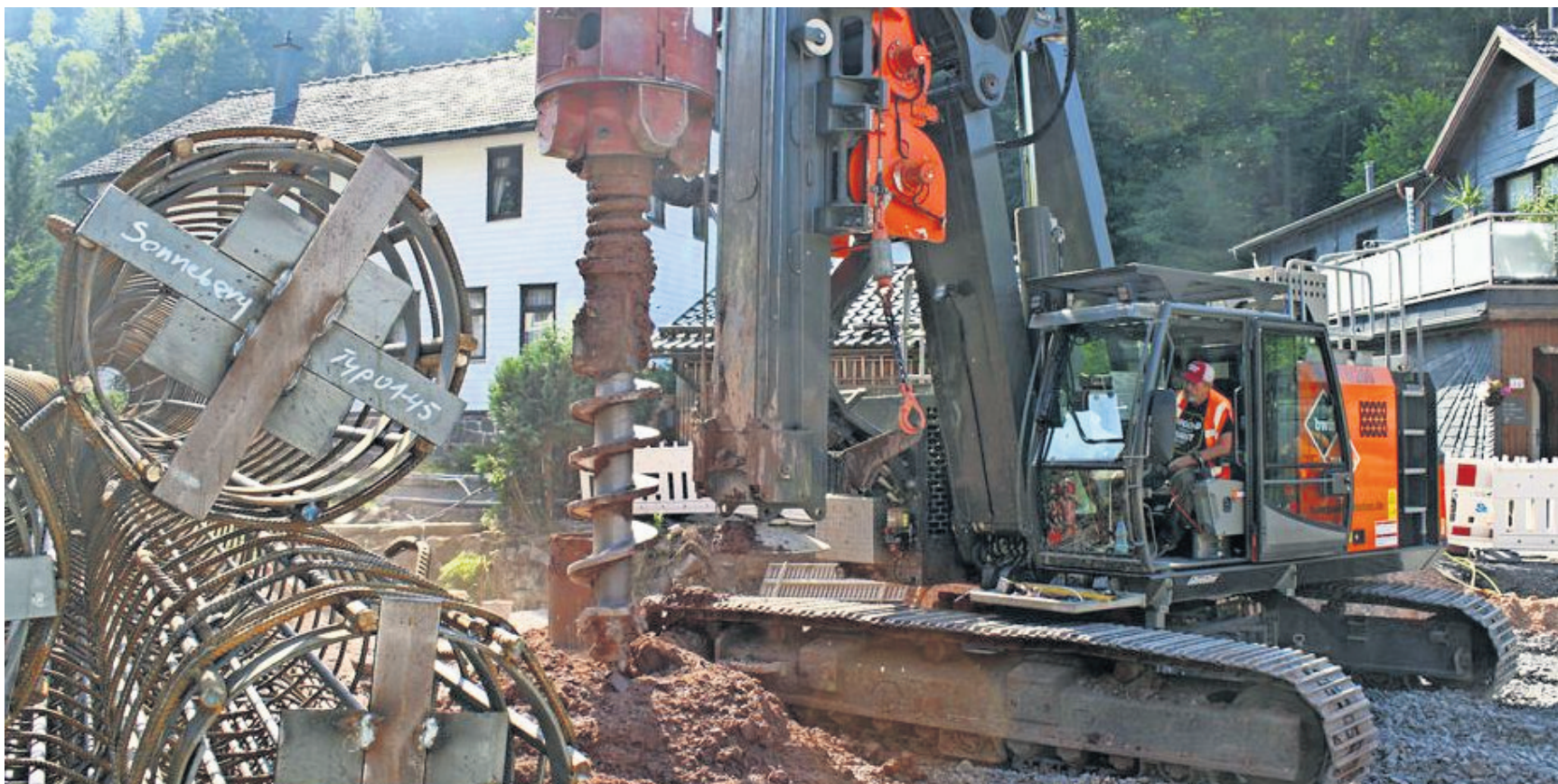
Der Bohrbagger im Einsatz - links im Bild die Bewehrung für die zu betonierenden Bohrpfähle
