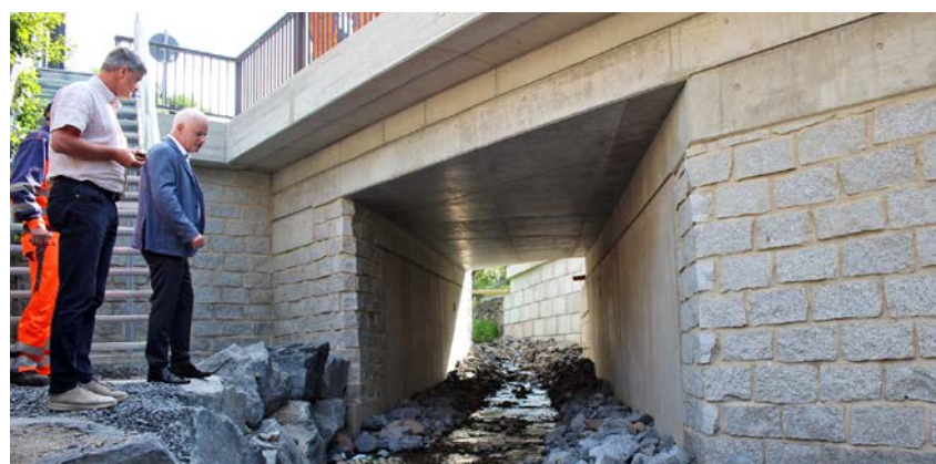
Andreas Meusel vom Bau- und Vergabeausschuss des Kreistages Sonneberg und der amtierende Landrat Jürgen Köpper begutachten das Brückenbauwerk
